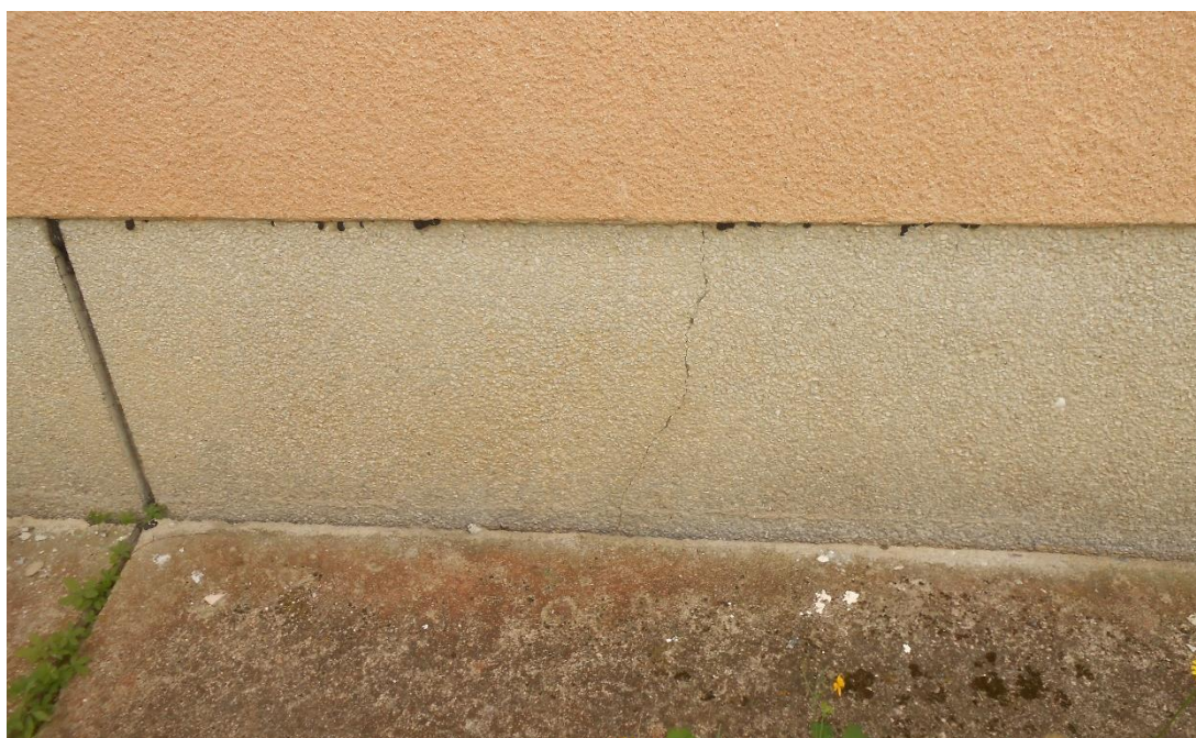
Slika šte. 4: razpoka plošče zidnega nastavka
