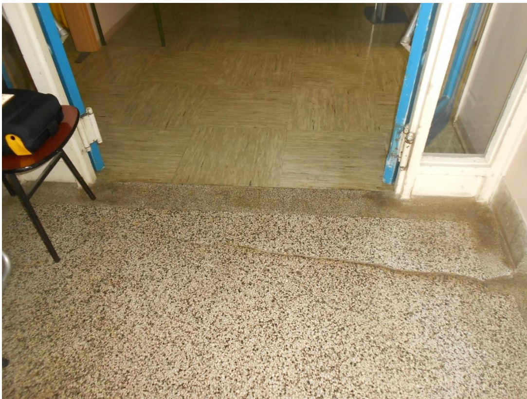
Slika štev. 6: razpoka teraso tlaka vetrolova na stiku z osnovnim objektom
