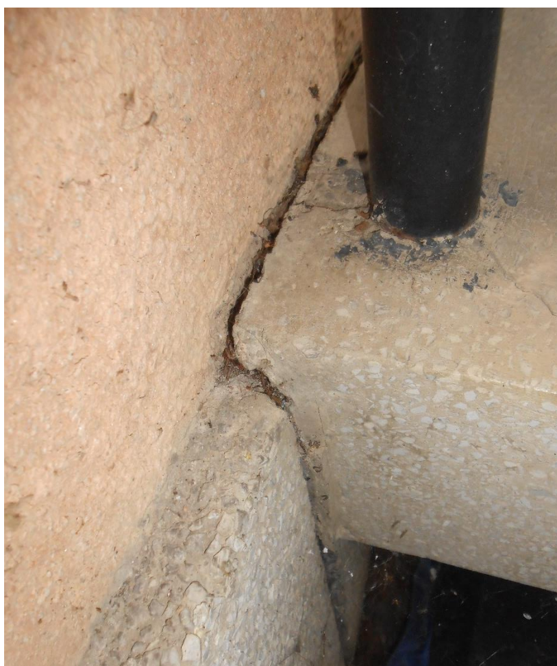
Slika šte. 5: razpoka in posedanje zunanjega stopnišnega podesta na SZ fasadi
